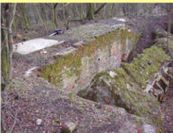
Die gemauerte Einfassung des Sammelbeckens mit Resten der Deckenkonstruktion (rechts)
