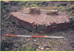
Rest des Deckentragwerks (gemauerte Bogenkonstruktion)
