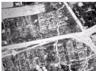
Ein Luftbild, das nach dem Abbruch der Gebäude entstand. Die hellen Linien der Fundamente geben Aufschluss auf die innere Struktur der Baracken
