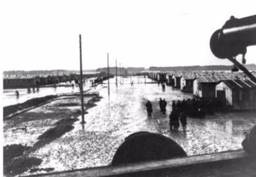
Südlicher Lagerabschnitt mit hölzernen Gefangenenbaracken
